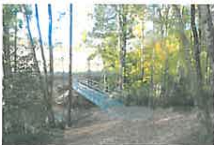
Installation d'une passerelle permettant de faire le tour de l'étang
