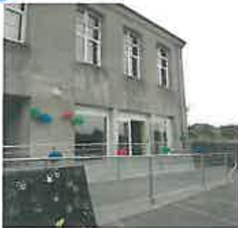
Création de la salle d'activités periscolaires ...
