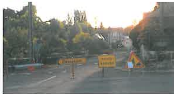
Route barrée + Travaux
