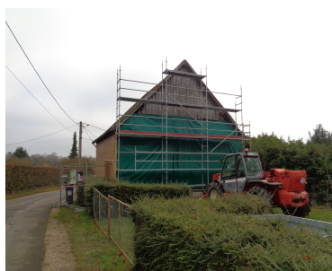
Restauration du hangar communal
