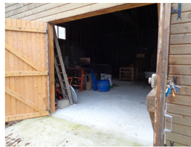
Réalisation d'une chape au hangar communal
