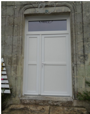
Remplacement de la porte de la mairie
