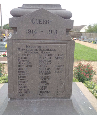
Remise en état du monument aux morts Rebouchage des fissures Restauration des lettres Cette réfection à été financée par les anciens combattants et par le don d'un citoyen
