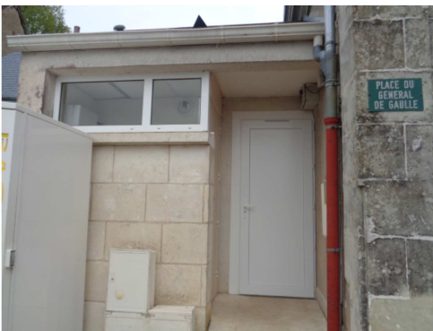
Remplacement de la porte annexe de la Mairie
