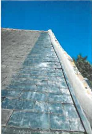
Réparation du toit suite aux infiltrations d'eau qui ont causé de gros dégâts à l'intérieur de l'église
