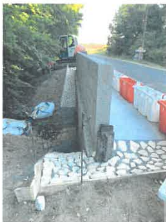
Réfection du pont sur la route de Marray suite à son endommagement par l'installation du réseau de la fibre
