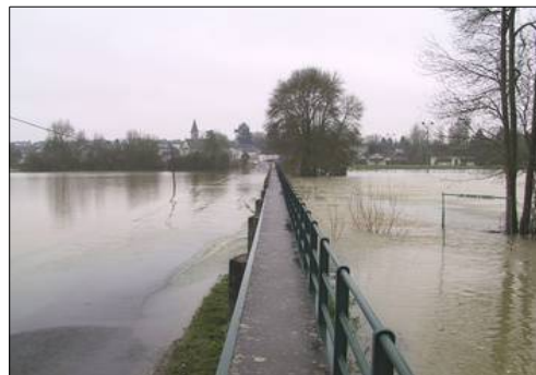
Crue de l'Indre, à Perrusson, janvier 2004
