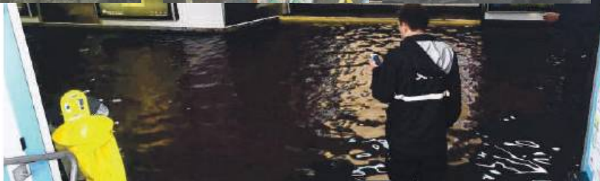
SAINT-PIERRE-DES-CORPS. A 9 h, hier matin, le couloir souterrain d'accès aux trains est devenu inaccessible, submergé par 30 à 40 cm d'eau en raison des fortes précipitations.
