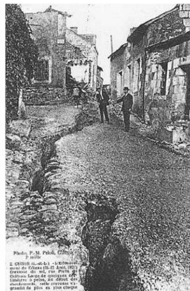
Affaissement de cavités souterraines à CHINON, le 14-15 août 1921
