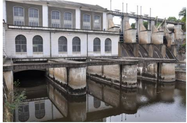
Barrage de la Roche aux Moines
